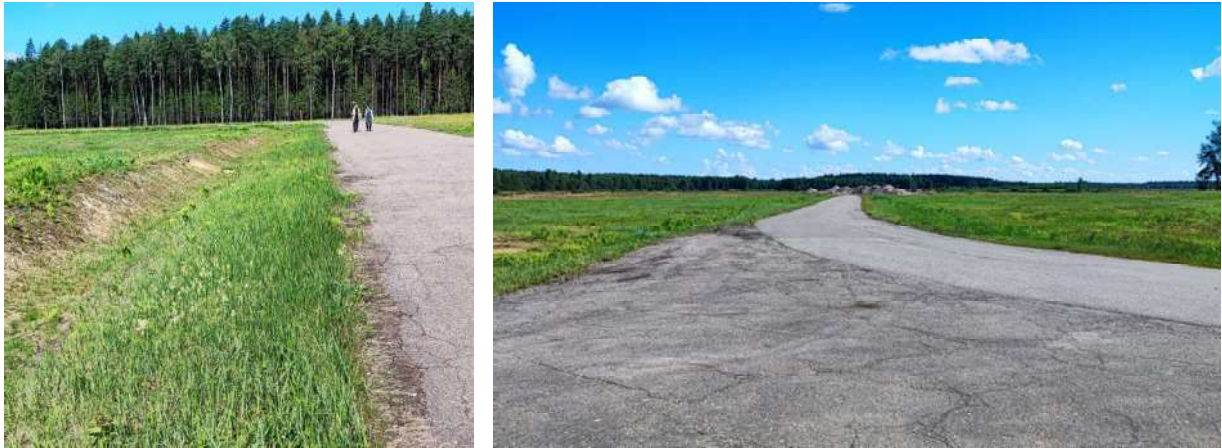
2 pav. Projektuojamo kelio esama situacija
